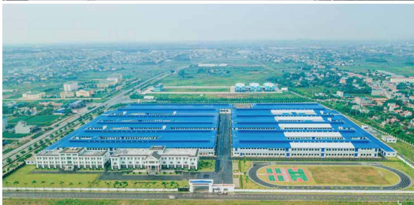
NHÀ MÁY VIENERGY VIENERGY공장
