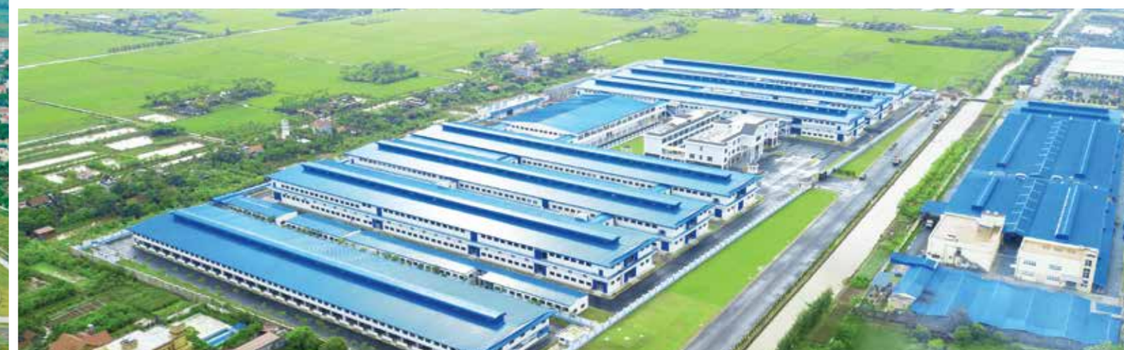
NHÀ MÁY VIET POWER VIET POWER 厂房
