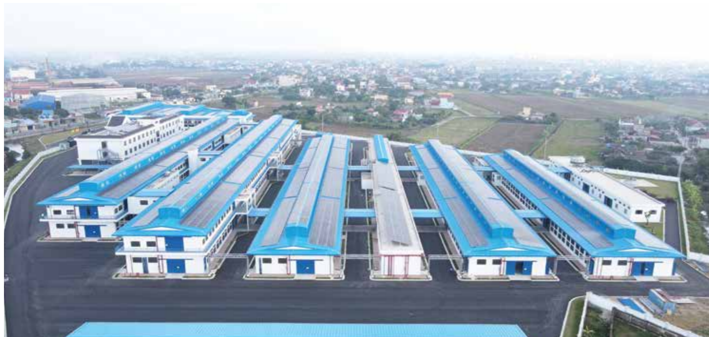
NHÀ MÁY NICE POWER NICE POWER 厂房
