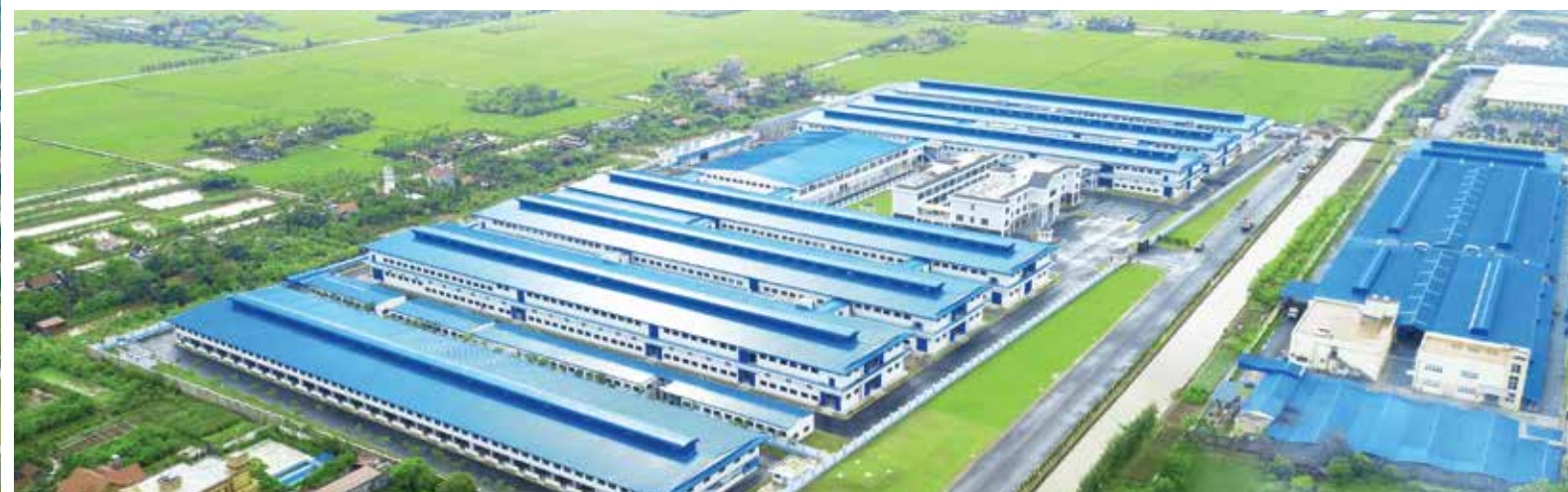
NHÀ MÁY VIET POWER VIET POWER FACTORY
