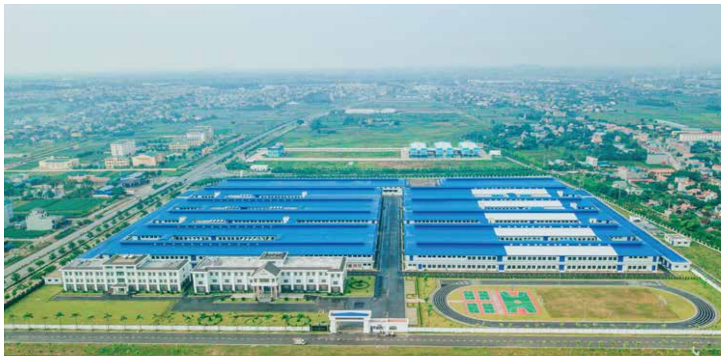
NHÀ MÁY VIENERGY VIENERGY 공장
