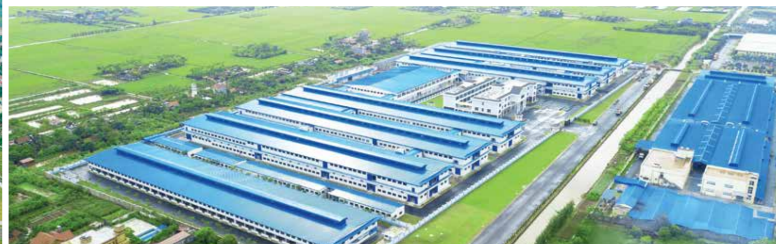
NHÀ MÁY VIET POWER VIET POWER FACTORY
