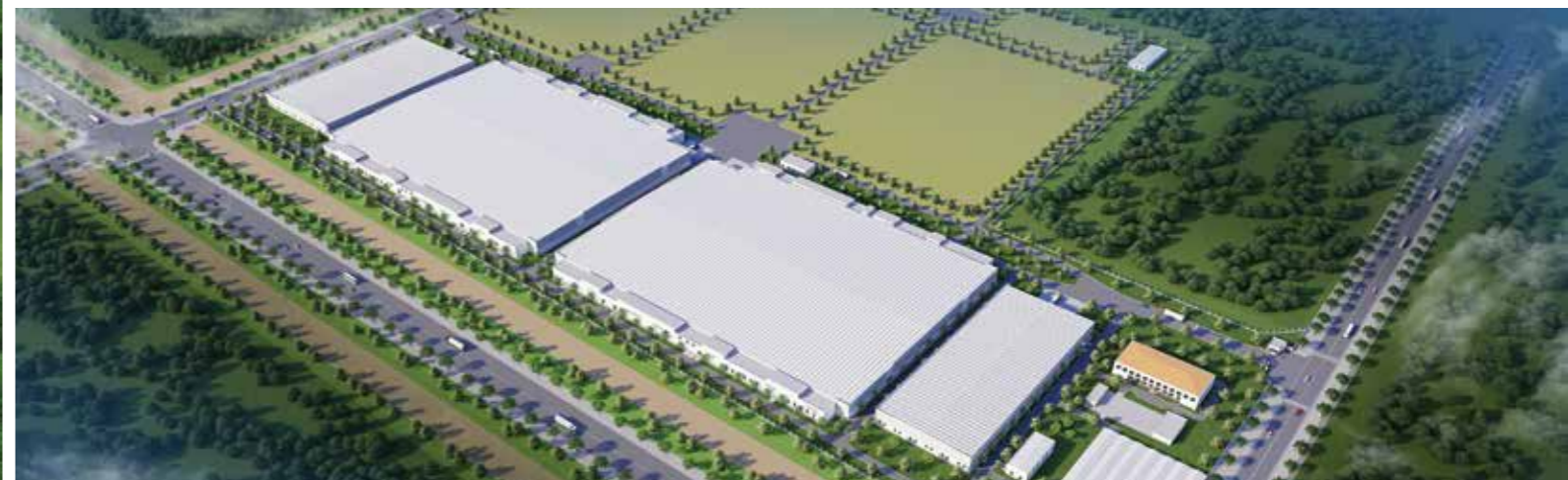
NHÀ MÁY TEXHONG NGÂN QUANG 天虹银光厂房
